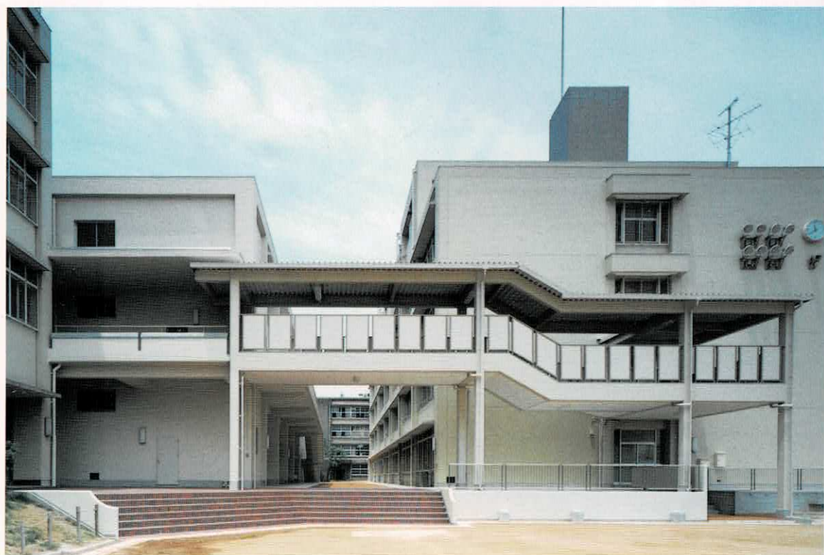
本館一体育館一南館の渡り廊下
