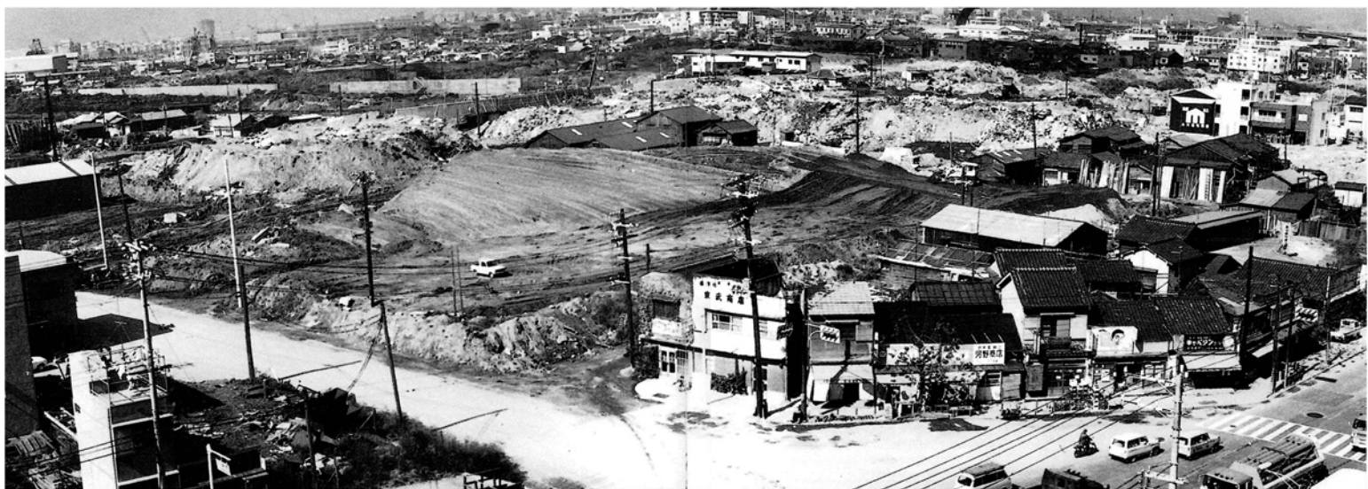
盛土工事が進む小林町付近S47年
